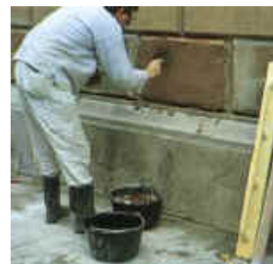
Pudsning med kalkmørtel. Foto:
